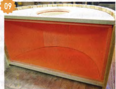
09 Основание домика утеплил жёстким утеплителем. Такой же утеплитель уложил внутри домика.
