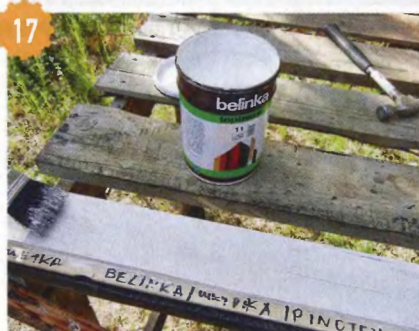
17 Покрытие базового слоя светлым тоном.
