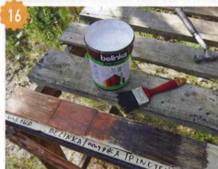
16 Окрашивание с зачисткой: окраска базовым тёмным тоном.
