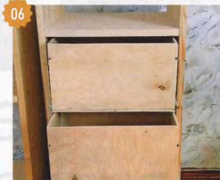
06 Выдвижные ящики предварительно установил на свои места без лицевых панелей.
