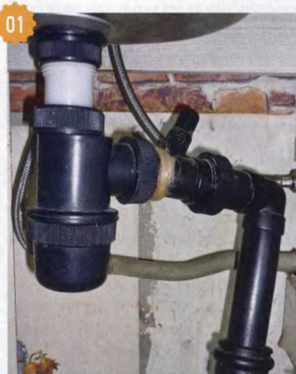
При замене сифона убираем всю старую подводку от мойки до раструба канализационной трубы.
