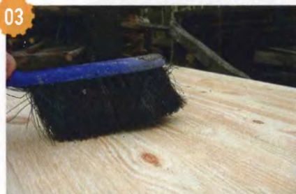
03 Очистка поверхности обработанной столешницы от пыли мягкой щёткой.
