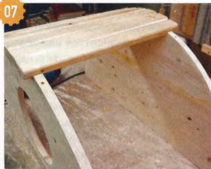
07 Такие же отверстия сверлил на кромке стенок, после чего установил очередной брусок.
