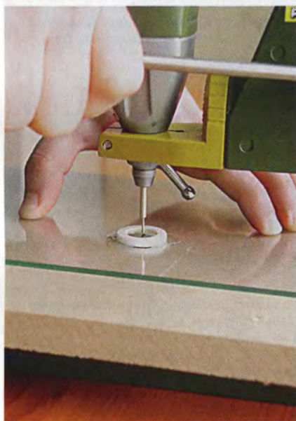
При сверлении стекла дрель или бормашину следует установить в сверлильную стойку.
