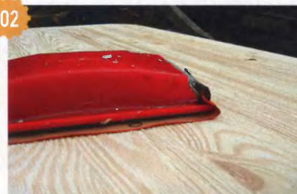
02 Шлифовка мелкой шлифовальной шкуркой.
